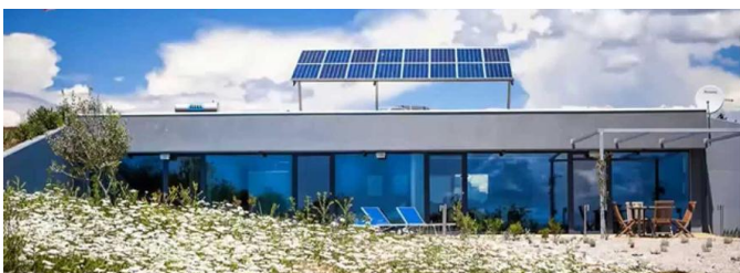
Sl. 4. Kuća sa solarnim panelima u Hrvatskoj, Krk, 2013 god. [15]
