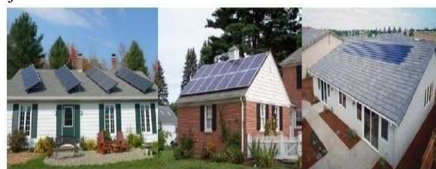
Najmanje integrisan (BAPV sistem) Više integrisan (BAPV sistem) Potpuno integrisani (direktno montirani BIPV sistem)
